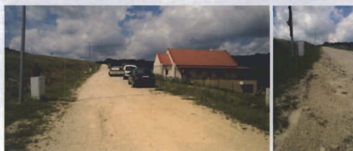
kimosódott, útszakasz/kátyúsodás
