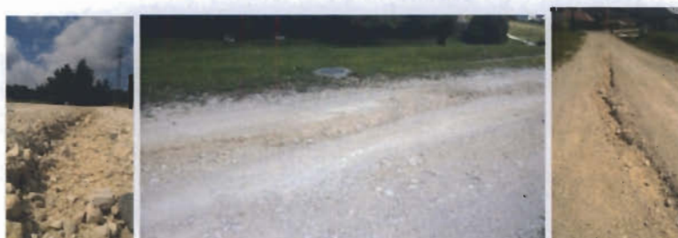
kimosódott, útszakasz/kátyúsodás
